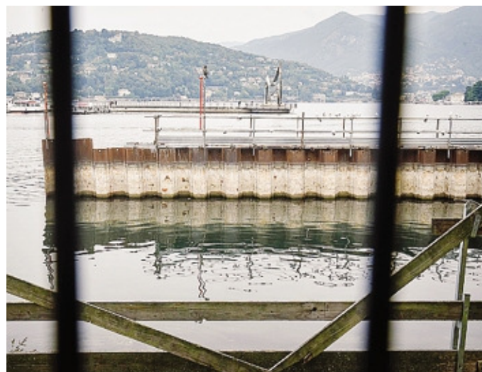
Il cantiere delle paratie, ancora completamente bloccato
